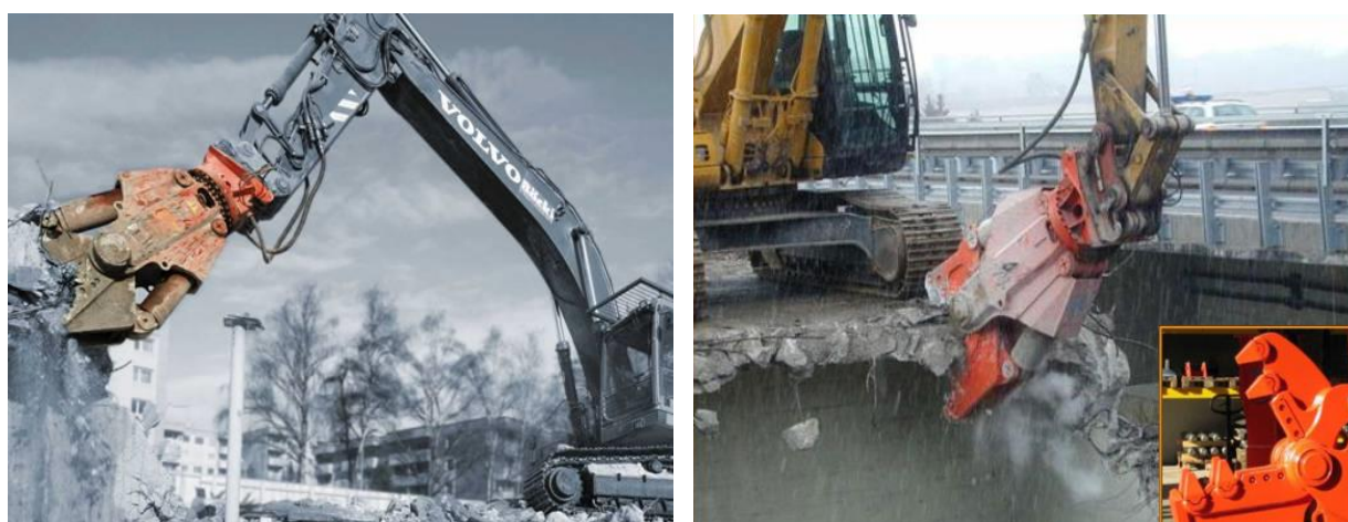
1.16 Сурет – Темір бетонды үйіндіні бөлу барысында қолданылатын гидроқайшылар
