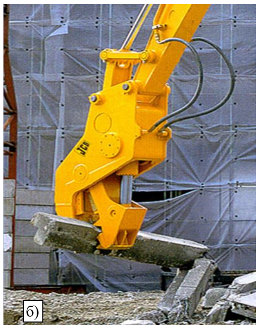
1.9 Сурет- Эскаватордың қауғағына орнатылған гидроқайшылар
