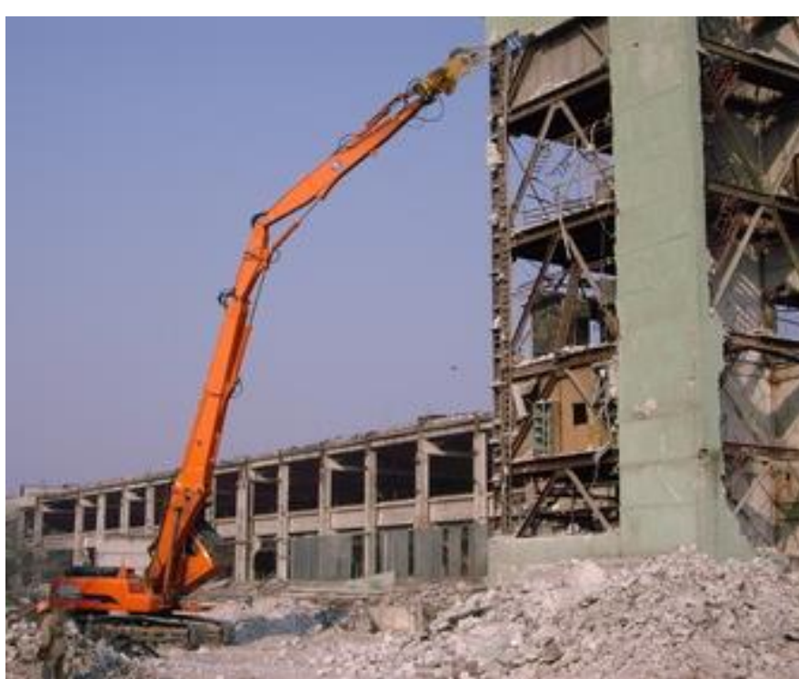
1.17 Сурет–Экскаватордың қауғасына биікте жұмыс істеу үшін гидроқайшыларды орнату
