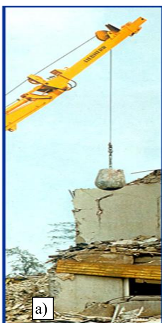
1.1 Сурет – Шар-бабының көмегімен барысында ғимараттарды қирату(а) және экскаваторлық гидрожүйесіне қосылған гидравликалық құралдың жұмысы (б)
